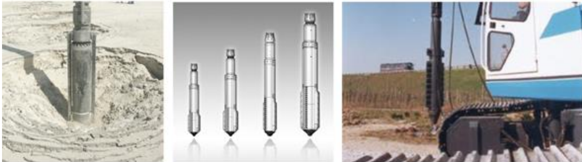
Vibroflottazione con vibratore di profondità
